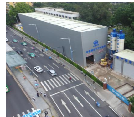
D4 地铁盾构工程包裹式围蔽
