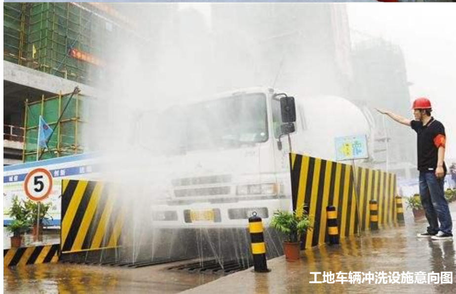
工地车辆冲洗设施意向图
