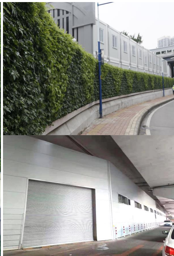
地铁全包裹式围蔽意向图
