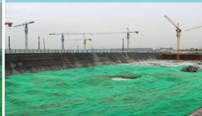
建筑土方开挖
