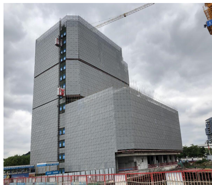
D2 钢管脚手架挂冲孔钢板网
