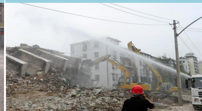
拆除工程降尘
