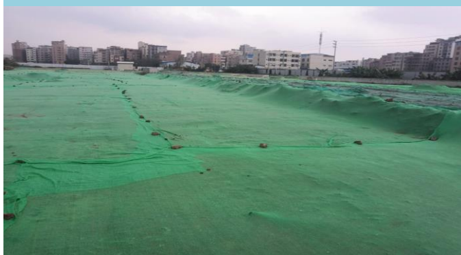
工程渣土、建筑垃圾
